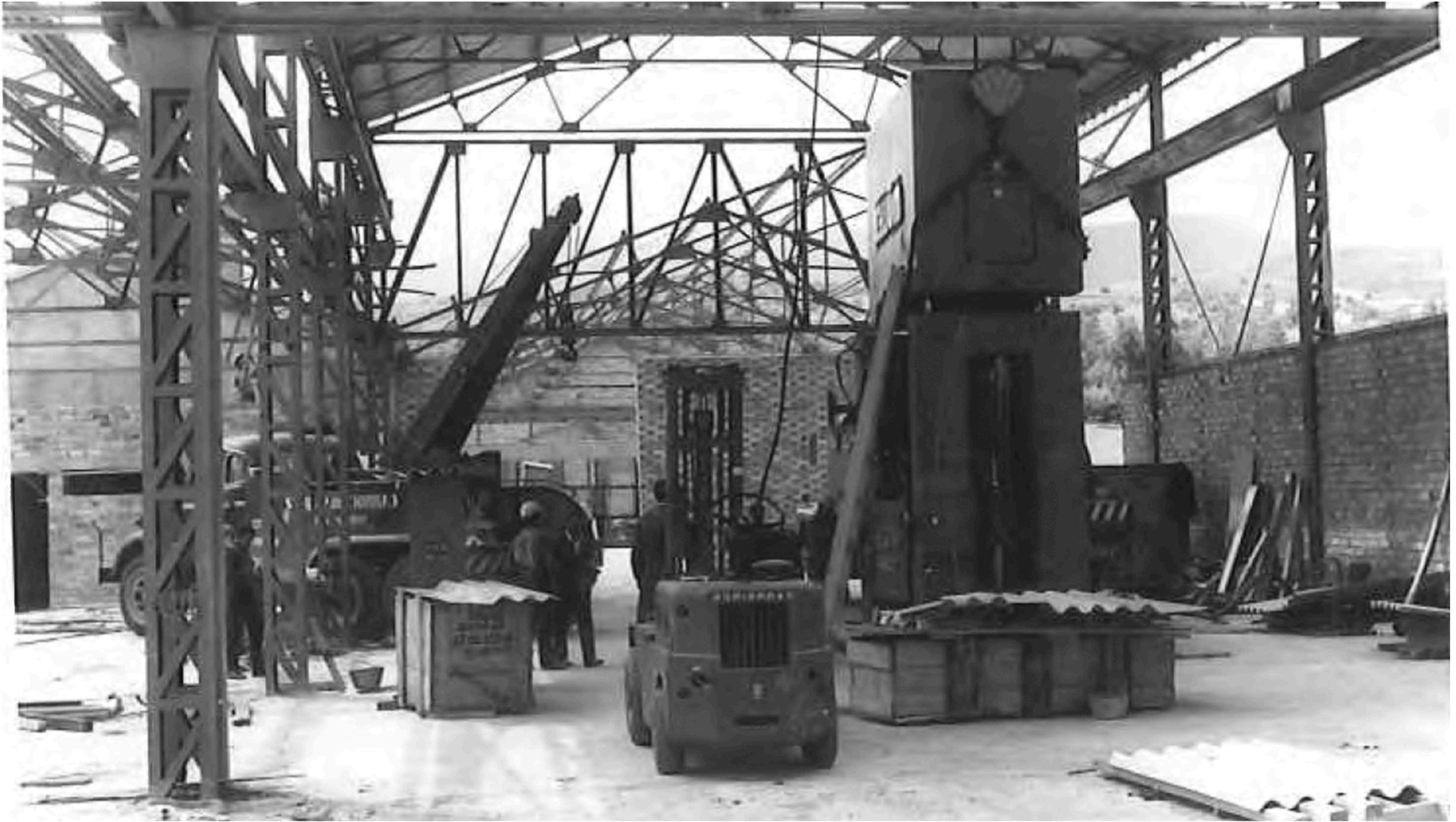
Montaje de la planta de Pulianas en los años 60
