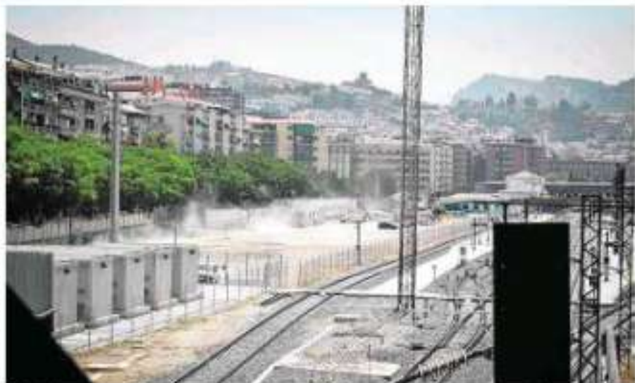
Vista de la estación de trenes con la parcela, a la izquierda, donde se construirá el aparcamiento. J. C. CARAZO
